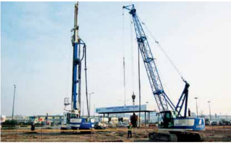
Singapore Edificio commerciale residenziale E6050 – R240 Pali trivellati ø 600-1200 mm.
